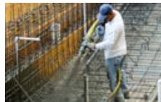
7 bis 12 bar: Spritzbetonanwendungen
