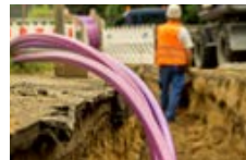
12 bar: Kabeleinblasen und Bohren
