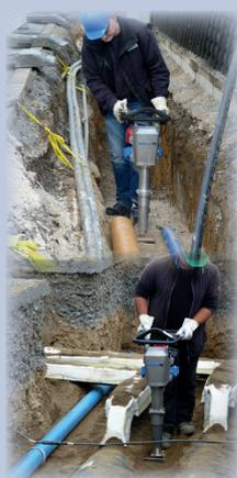
Der neue, besonders leichte Vibrationsstampfer SRV 300 wurde speziell zum Unterstopfen von Leitungen und Rohren - für die Verdichtung in sogenannten Rohrzwickeln in Gräben - entwickelt.
